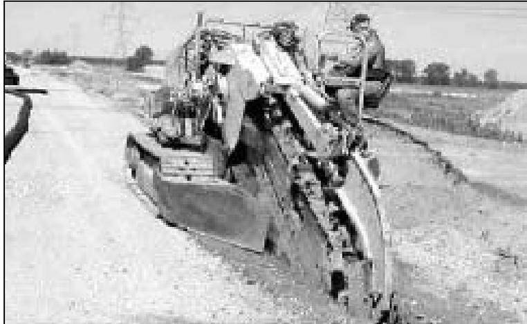
**Figure 10-4. Underdrain Trencher**
