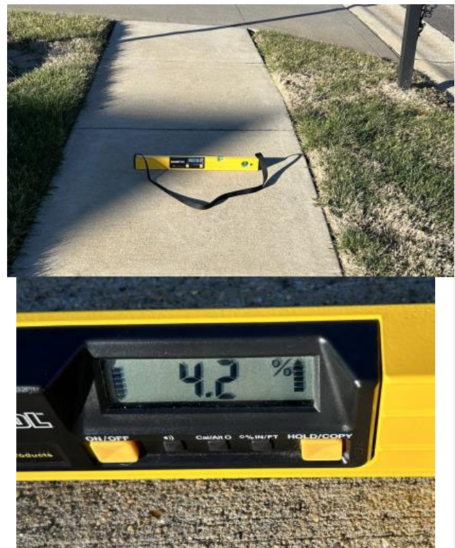
Example PAR with excessive cross slope
