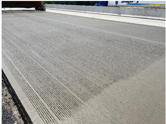
Figure 6-9 Longitudinal Tining
